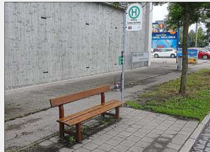
Diese dachlose Bushaltestelle in der Sollnau halten die Grünen für dringend verbesserungswürdig. Das führte fast zu einer Grundsatzzdebatte im Bauausschuss. Foto: Knopp
